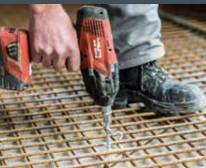
Basis: Engmaschige Armierung auf tragfähigem Untergrund.
