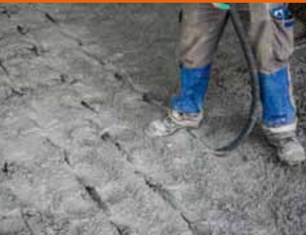
Kontrollierte Verdichtung, engmaschig mit Rüttelflasche ausgeführt.
