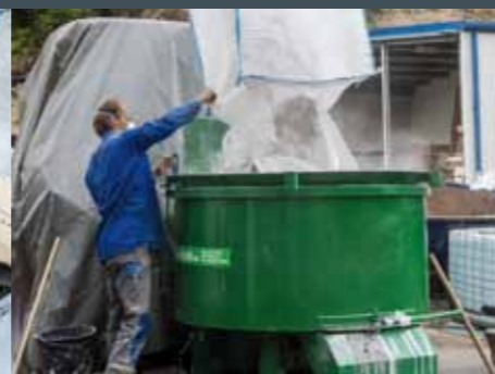
Maschinelle Mischung, mobil auf der Baustelle individuell ausgeführt.
