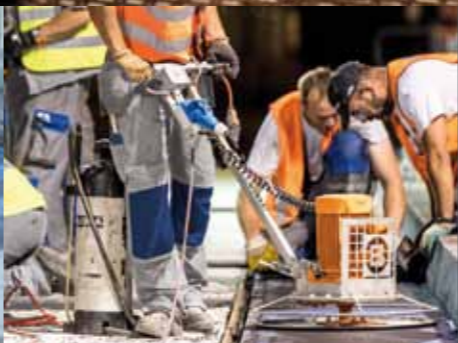
Glätter für die plane Oberfläche
