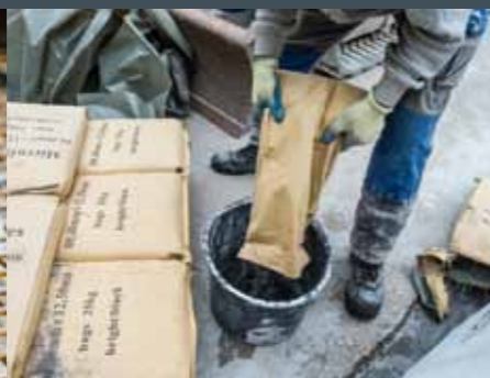
Materialmischung nach 'Rezept'. Zuschlagstoffe je nach geplantem Einsatz nach Biege- und Druckfestigkeit gefertigt.
