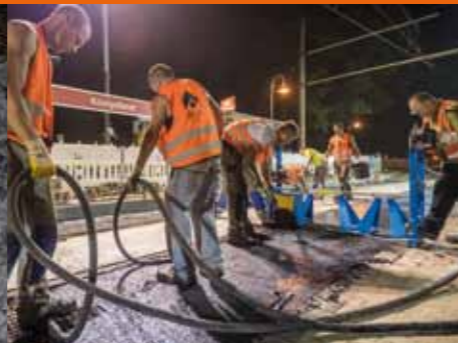
Ebener Einbau mit der Rüttelbohle.
