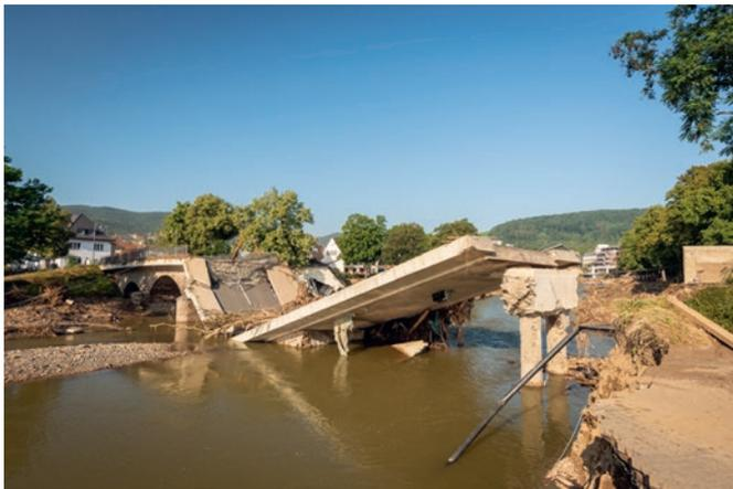
**Bild 6** Die zerstörte Ahrtorbrücke in Ahrweiler nach der Flut im August 2021
